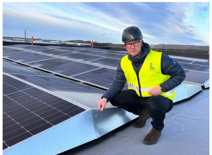
Installation av solceller på fastigheten Vindan 1 i Borås
